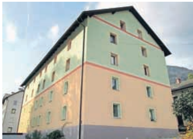
Stanovanci po prenovi prihranijo kar 45 odstotkov pri stroških ogrevanja.
